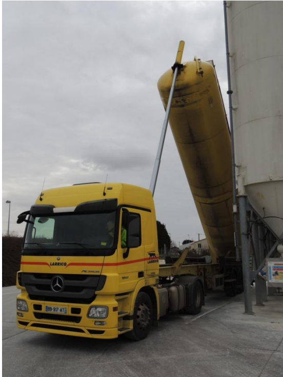
Le vidage du ciment de la citerne et le remplissage d'un silo de la centrale
