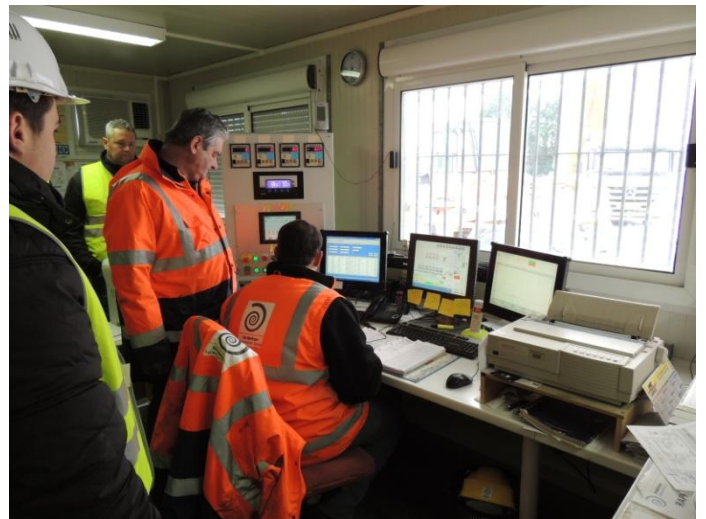
Le poste de commande de la centrale (entièrement automatisée)
