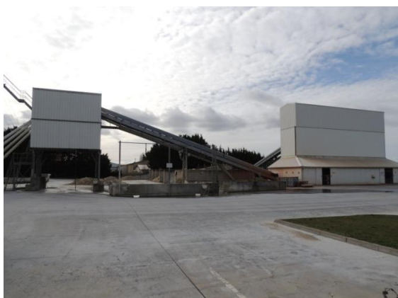
Vue d'une partie de la centrale
