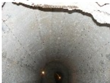
Voûte construite avec un coffrage en bois dont on peut voir encore les empreintes
