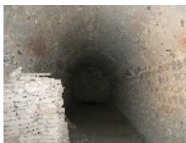
Voûte construite avec un coffrage en bois dont on peut voir encore les empreintes
